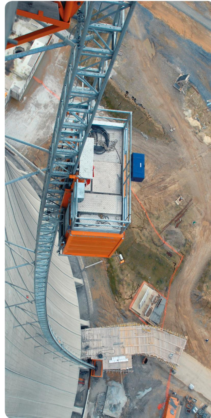
под кабиной установили подвижную кабельную тележку. Во избежание обрыва кабеля и для уменьшения натяжения при подъеме по направляющим с изменяющимся углом наклона конструкция была оснащена специальными роликами.
