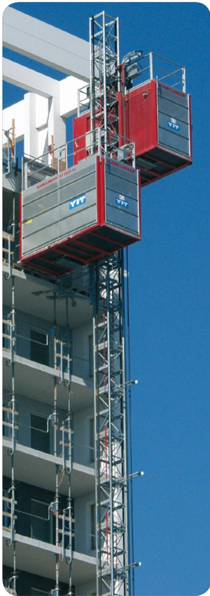
На строительном участке **Helsingin Cirrus** в районе Вуосаари, Хельсинки, использовалась модель подъемника с двумя кабинами **SC1837FL**. Длина кабины составляет 3,7 м. Каждая кабина оборудована боковой дверью шириной 3,5 м. Cirrus – это самое высокое жилое здание в Финляндии. Его высота составляет 86 м (282 фута). Здание имеет 28 этажей, на которых расположено 140 квартир.
